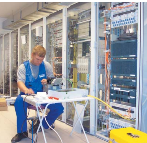
Konfektionierung einer LWL-Strecke mit Fusionsspleißgerät
